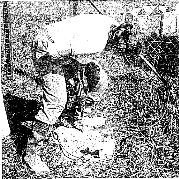
Abb. 2 (links): Abbau der EN-Station 42 Klippeneck – Gabriele Heinlein beim Aufstemmen der Fundamente mit schwerem Gerät, ...
