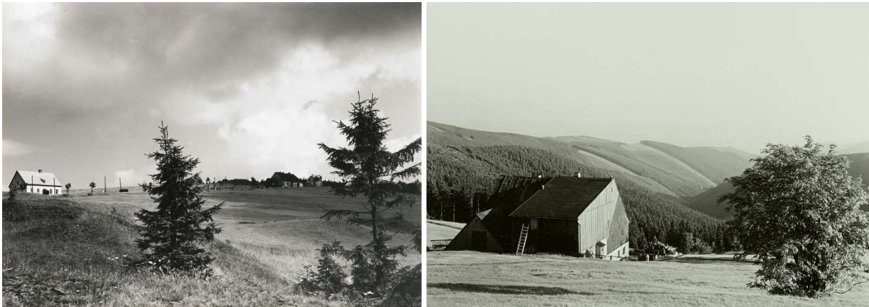
Sonnenwirbelhäuser an der „Abbruch“kante am Keilbergs (heute am Skigebiet Neklid)
