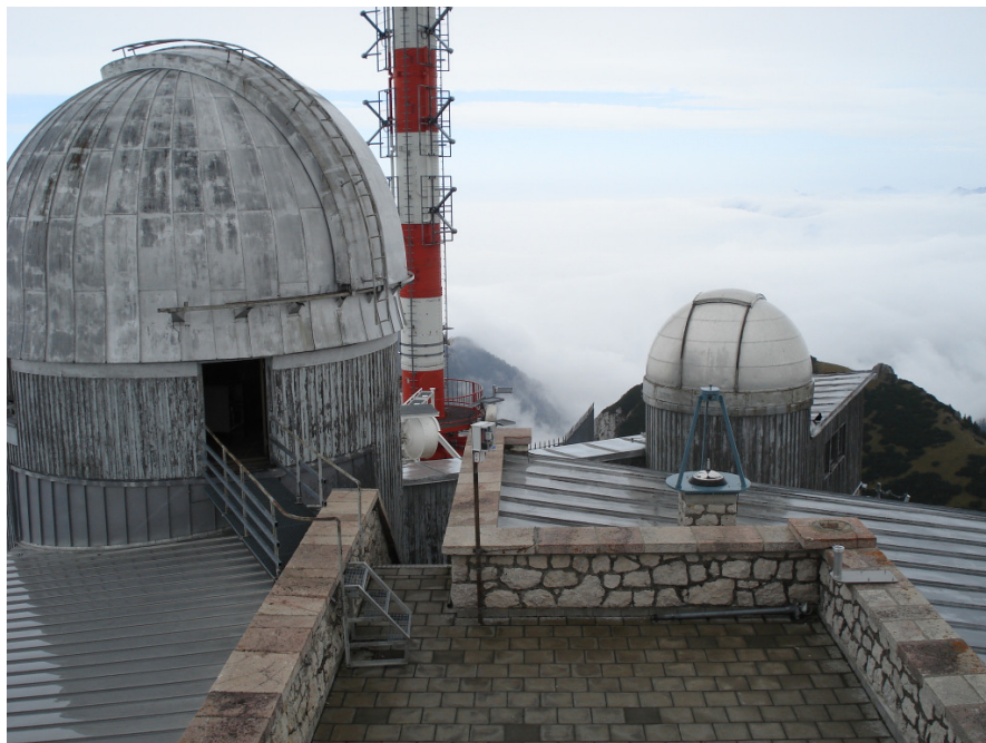
Abb. 2: Ciao Wendelstein: Die all-sky Kamerastation 88 musste im Juli 2008 leider ihren Platz am 1850 Meter hoch gelegenen Standort auf dem Wendelsteingipfel räumen.
